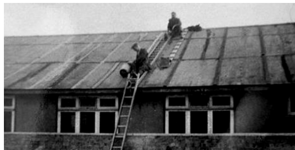
Manutenzione all'esterno di uno hut...
